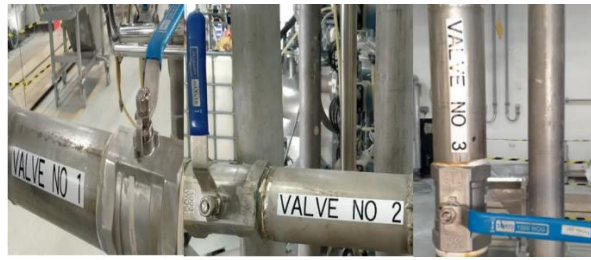
Gambar 6. Manual Valve Setelah Perbaikan (Sudah Beridentitas)
